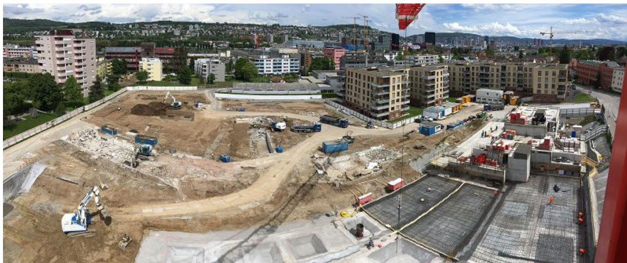
Beginn Bauphase Etappe 2
